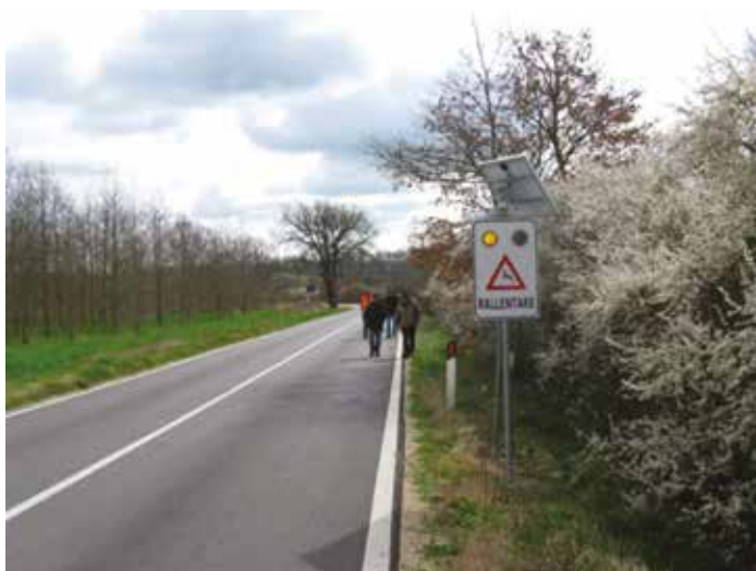
La segnaletica di avviso preventivo autoalimentata con pannello solare
